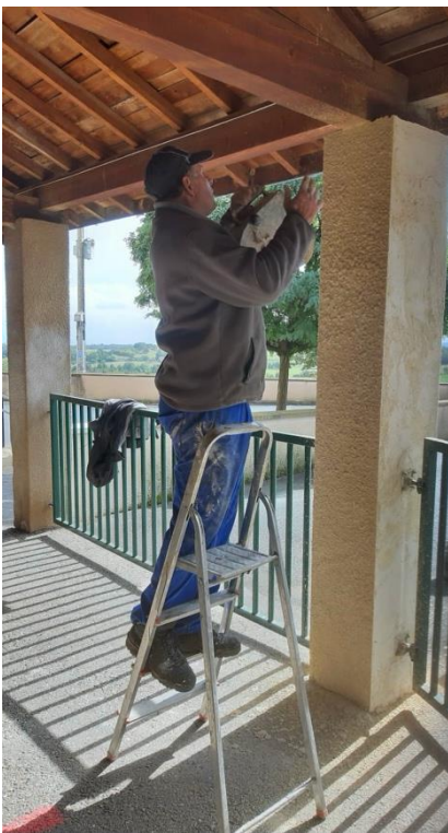
Recrèpissage du poteau du préau de l'école
