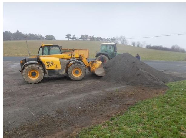
Prêt de matériel agricole pour gravillonnage du chemin chez Grou
